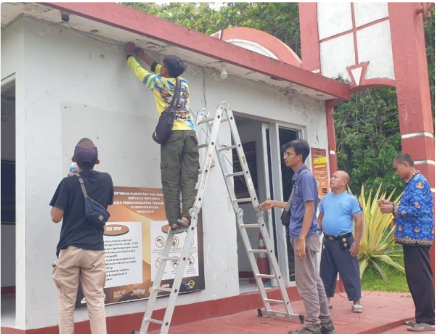
Pemasangan CCTV,DVR,dan NVR Oleh Petugas
