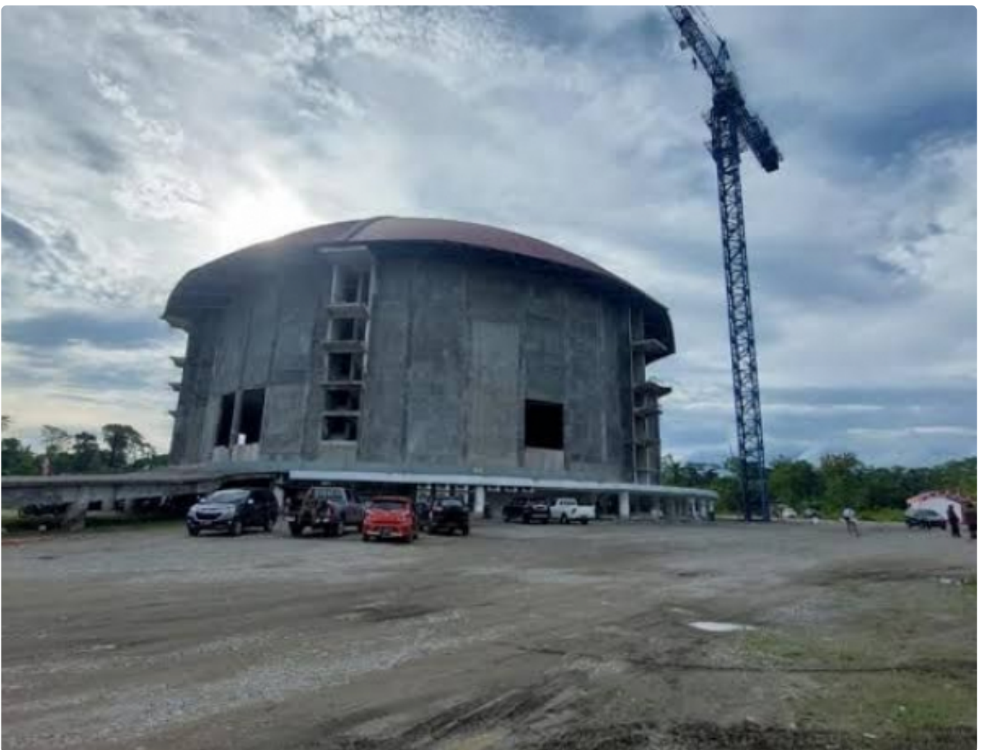
Pembangunan Gereja Kingmi Mile 32
