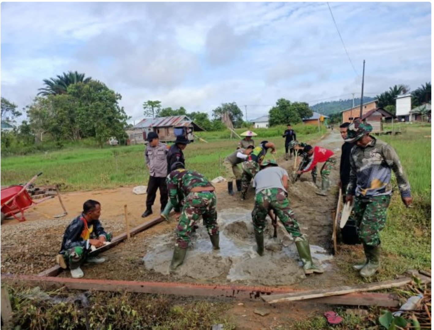
Kompak, Satgas TMMMD ke- 118 Bareng Warga Semenisasi Jalan di Desa Malinau Sebrang
