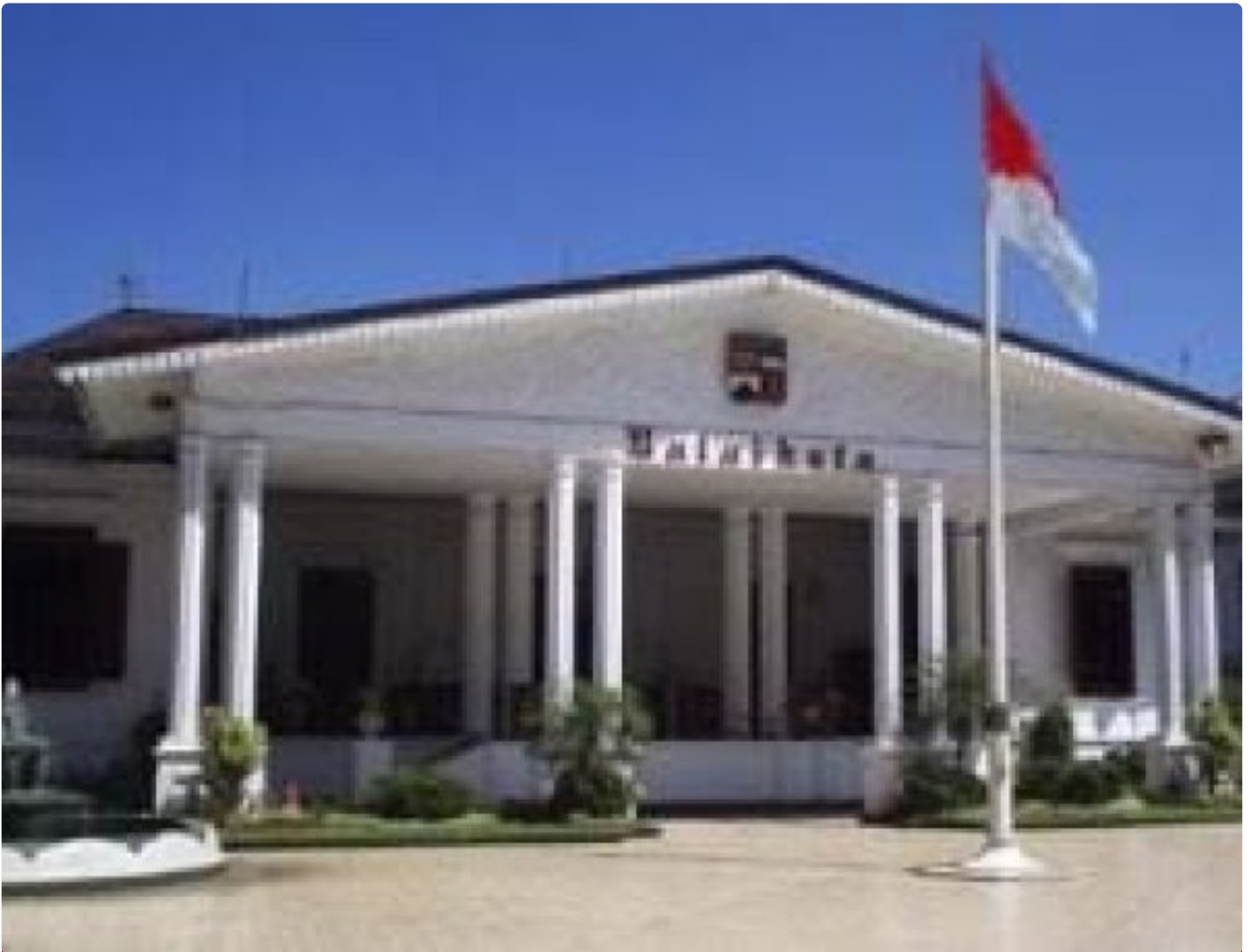
Photo Gedung Wali Kota Bogor
